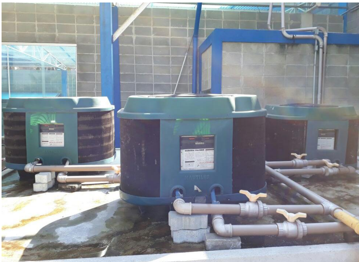
Figura 3.3 – Bombas de calor para atender o aquecimento da piscina pequena
